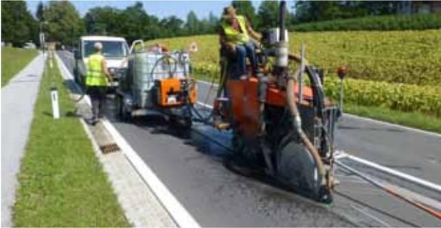
Kabelfräse der Fa. NANO-Trench für Kabelverlegung in der Asphaltdecke
