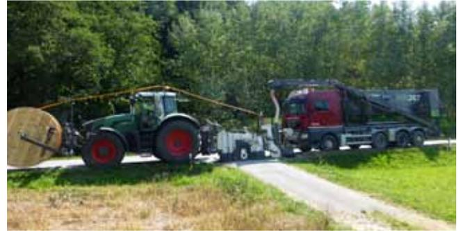
Kabelfräszug der Fa. DW-Tech für Kabelverlegung im Bankettebereich
